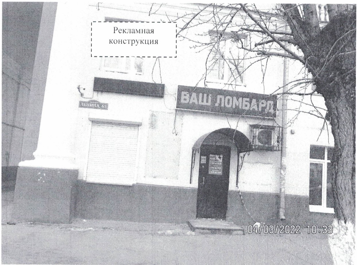
Фото № 1: Панорамный вид размещения рекламной конструкции
