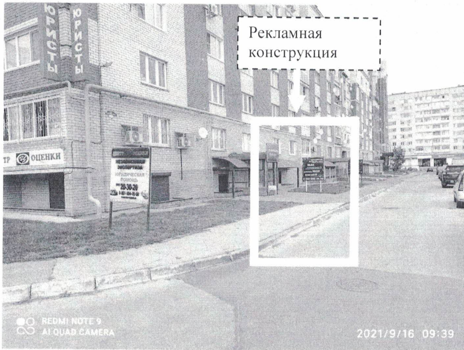
Фото № 1: Панорамный вид размещения рекламной конструкции
