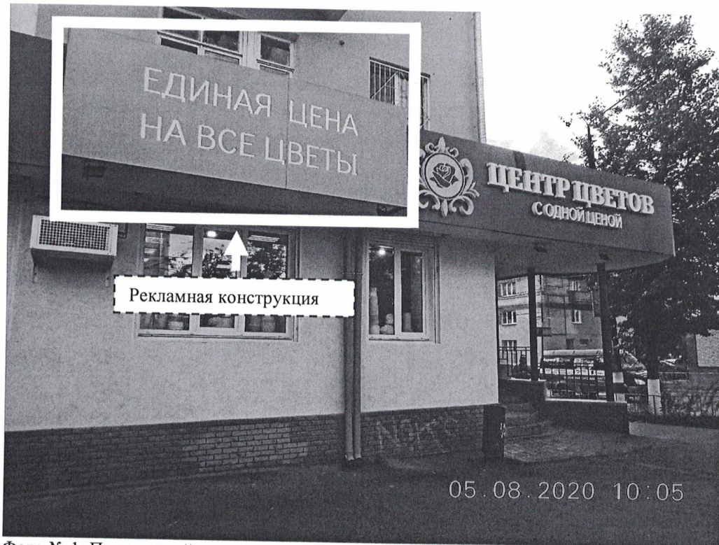
Фото № 1: Панорамный вид размещения рекламной конструкции
