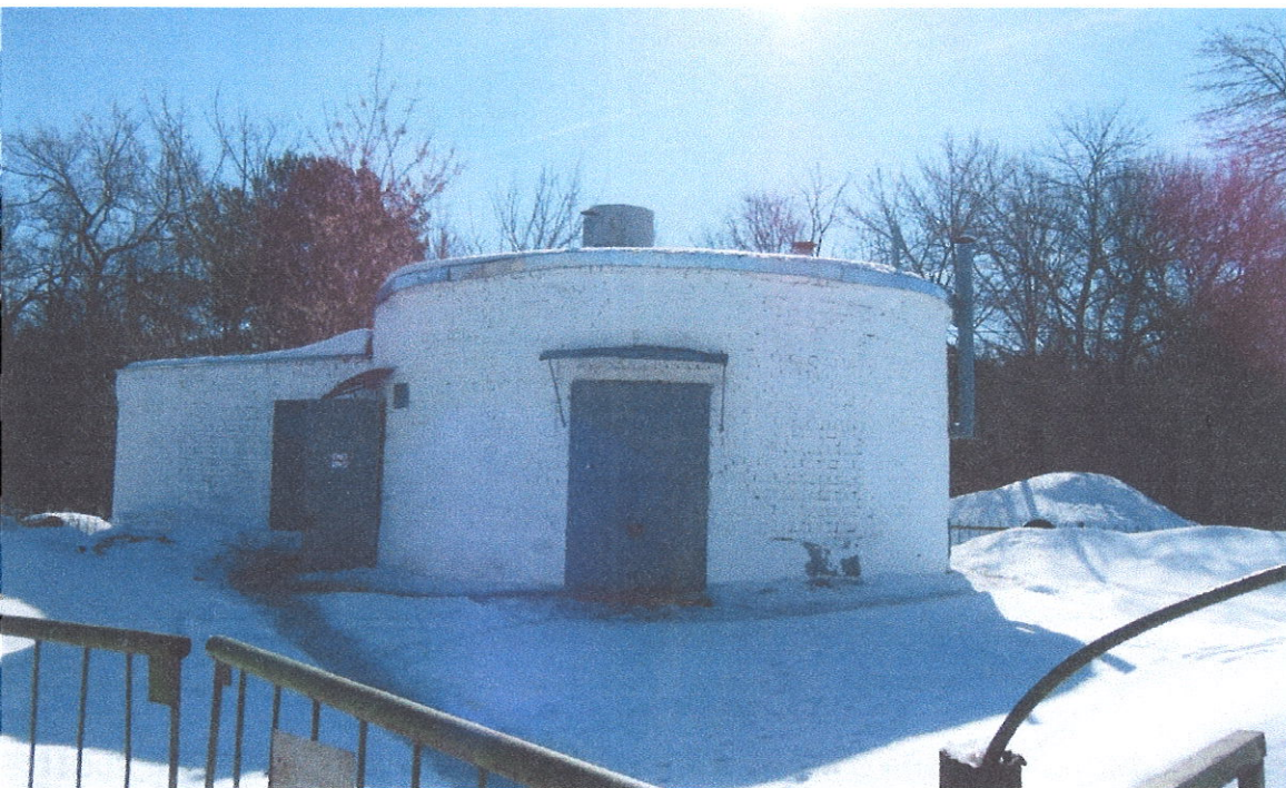
Здание насосной станции №2 п.Пушкино, инв. № 10035
