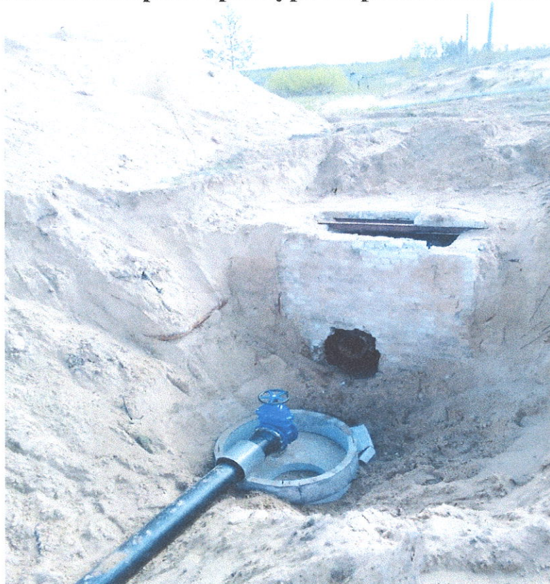
Колодец и запорная арматура сборного водовода ГВЗ
