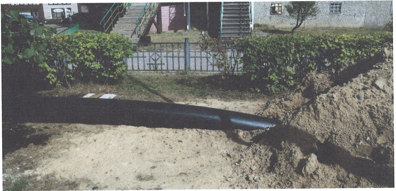
Прокладка трубопровода Ø300мм
