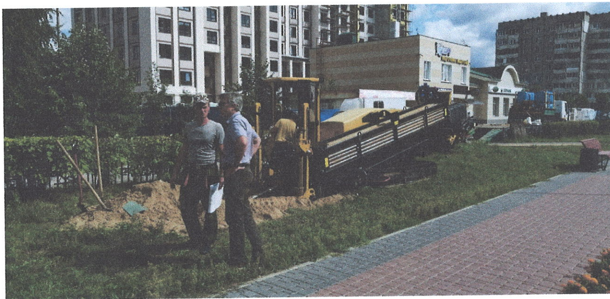
Реконструкция сетей водоснабжения на бульваре Космонавтов с использованием установки ГНБ
