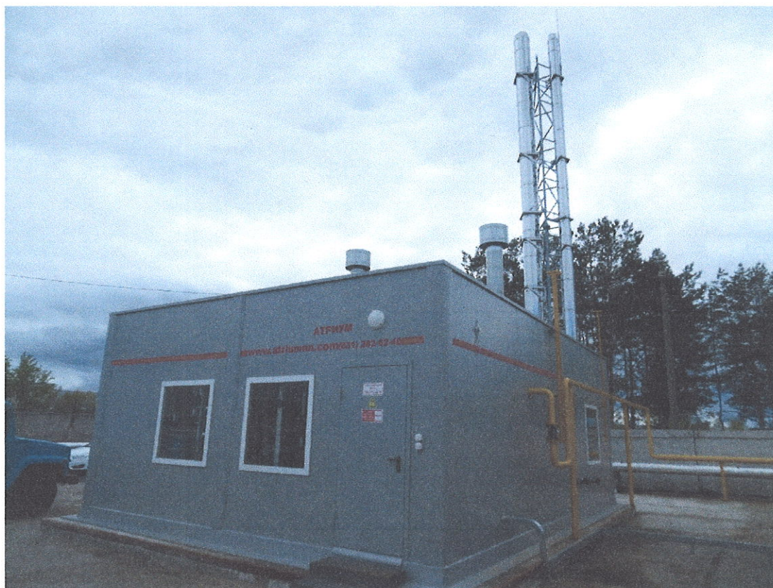
Блочно-модульная котельная
