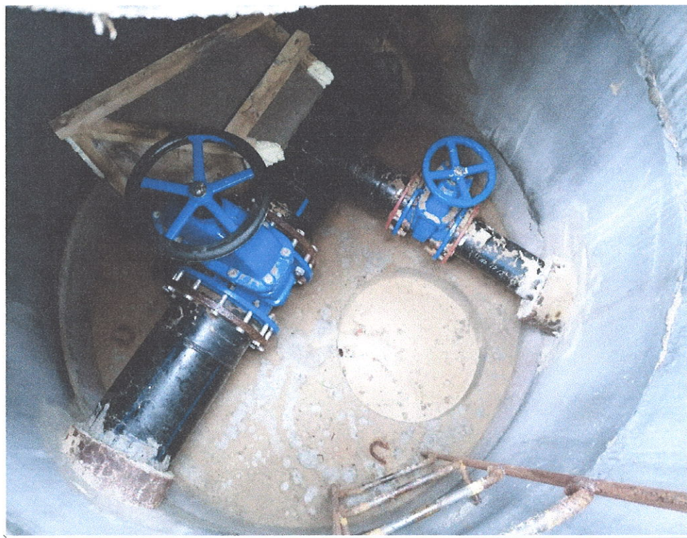
Колодец и запорная арматура сборного водовода ГВЗ
