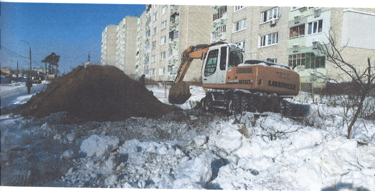
Прокладка канализационных сетей по пр. Ленина
