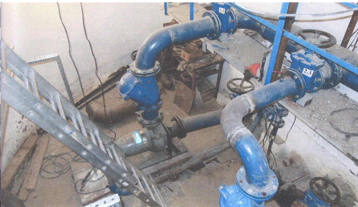
Производство работ по установке насосного оборудования, присоединенного к системе управления и электропитания КНС №2
