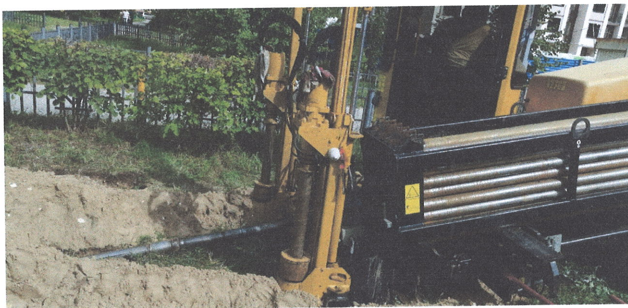
Установка горизонтально-направленного бурения (ГНБ)
