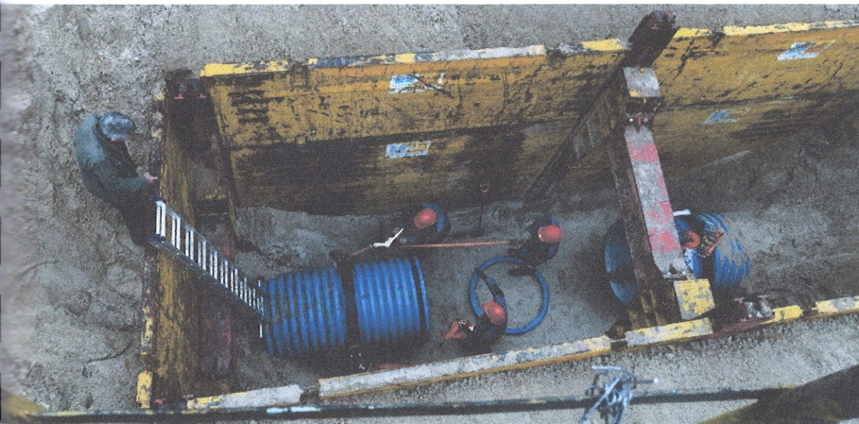
Главный канализационный коллектор, участок ул. Р. Удриса д.11 до ул. Терешковой д.4)
