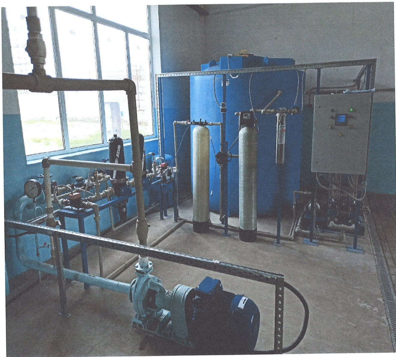
Автоматизированная система управления технологическим процессом водоснабжения ПХВ РОС
