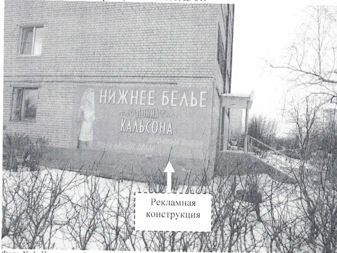
Фото № 1: Панорамный вид размещения рекламной конструкции
