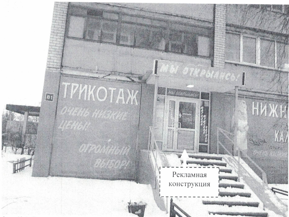
Фото № 1: Панорамный вид размещения рекламной конструкции
