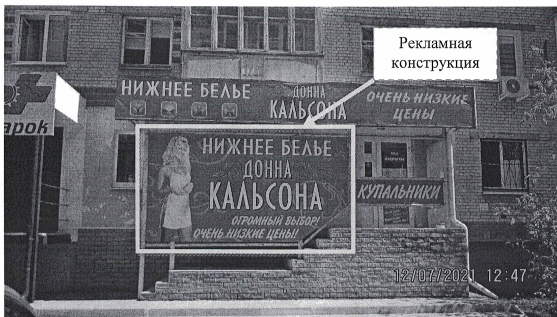
Фото 1: Панорамный вид размещения рекламной конструкции
