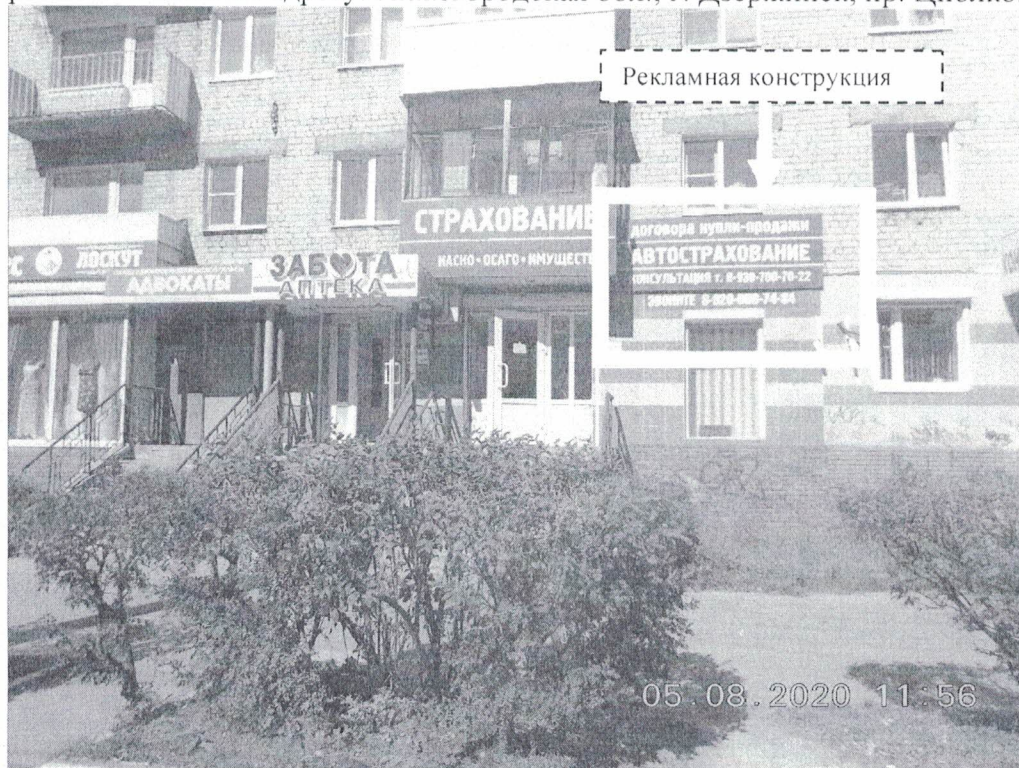
Фото № 1: Панорамный вид размещения рекламной конструкции
