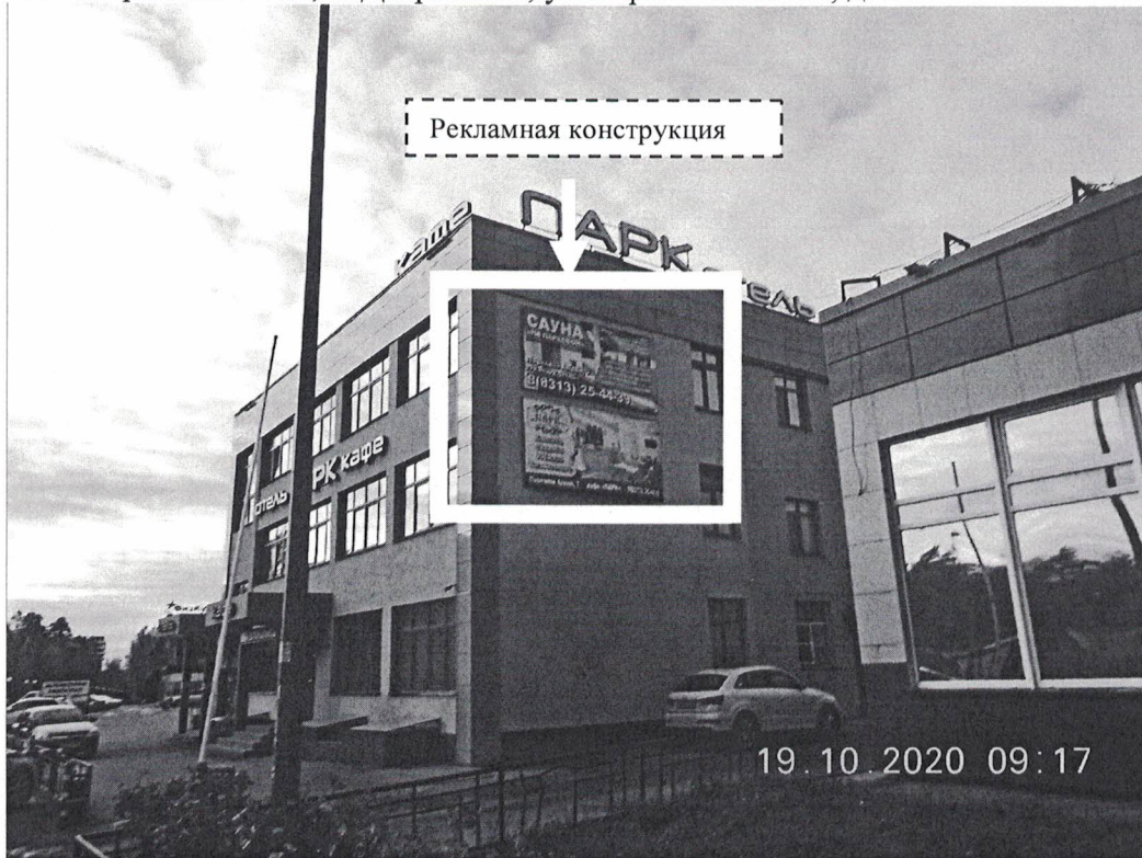
Фото № 1: Панорамный вид размещения рекламной конструкции
