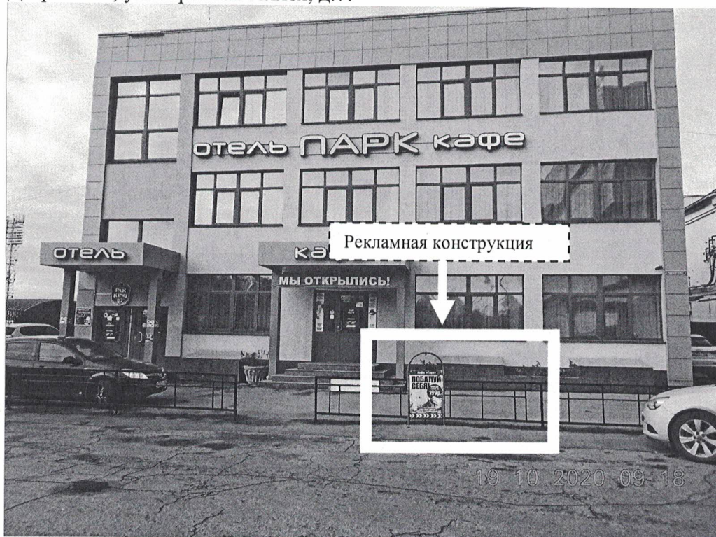
Фото № 1: Панорамный вид размещения рекламной конструкции
