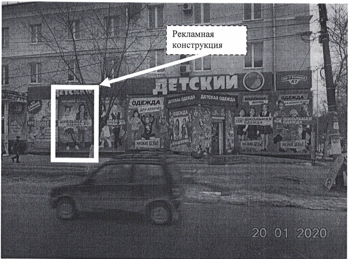
Фото № 1: Панорамный вид размещения рекламной конструкции
