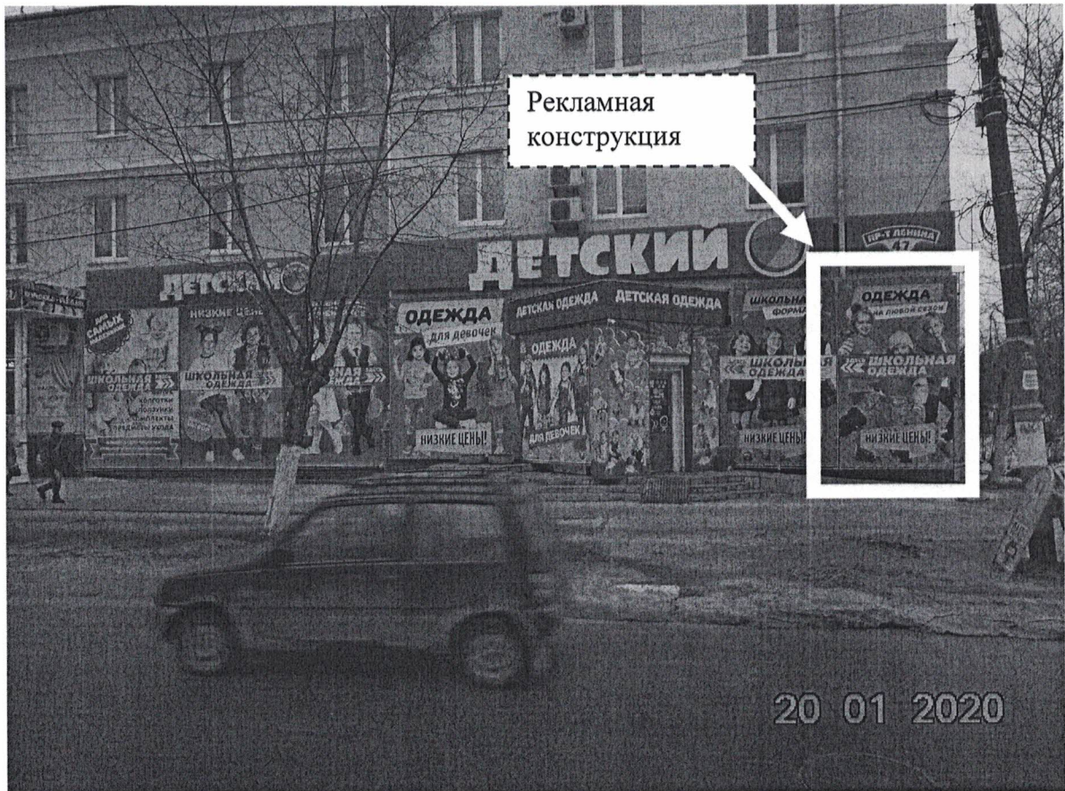
Фото № 1: Панорамный вид размещения рекламной конструкции
