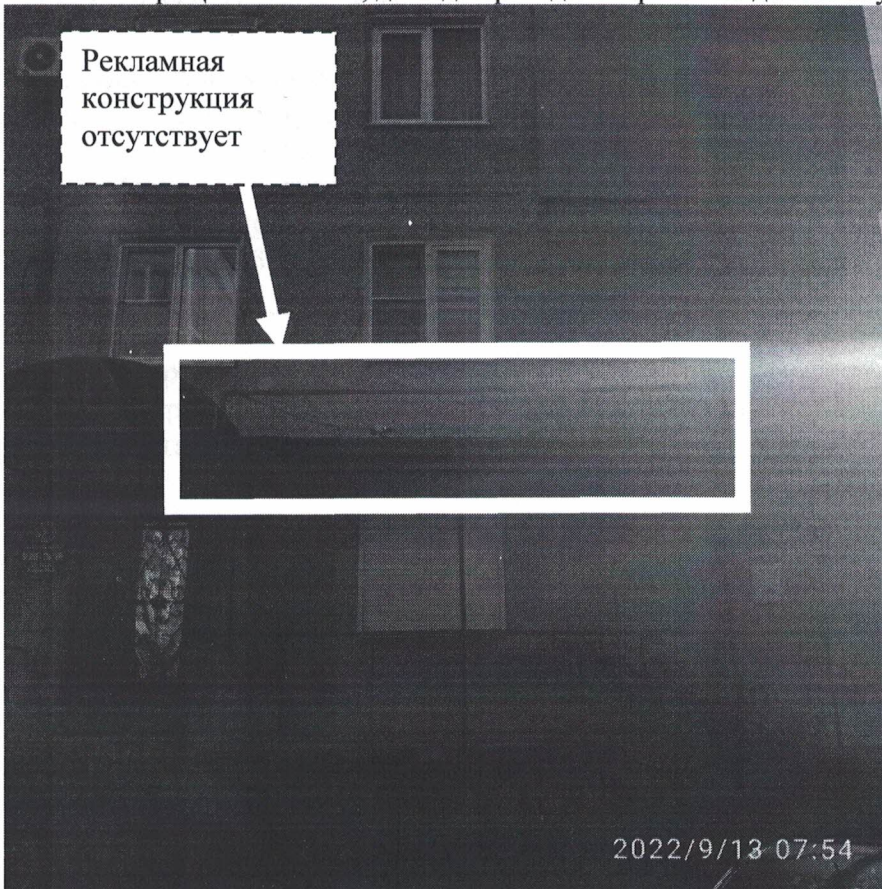
Фото №2: Пр. Циолковского, д. 50 после проведения работ по демонтажу.
