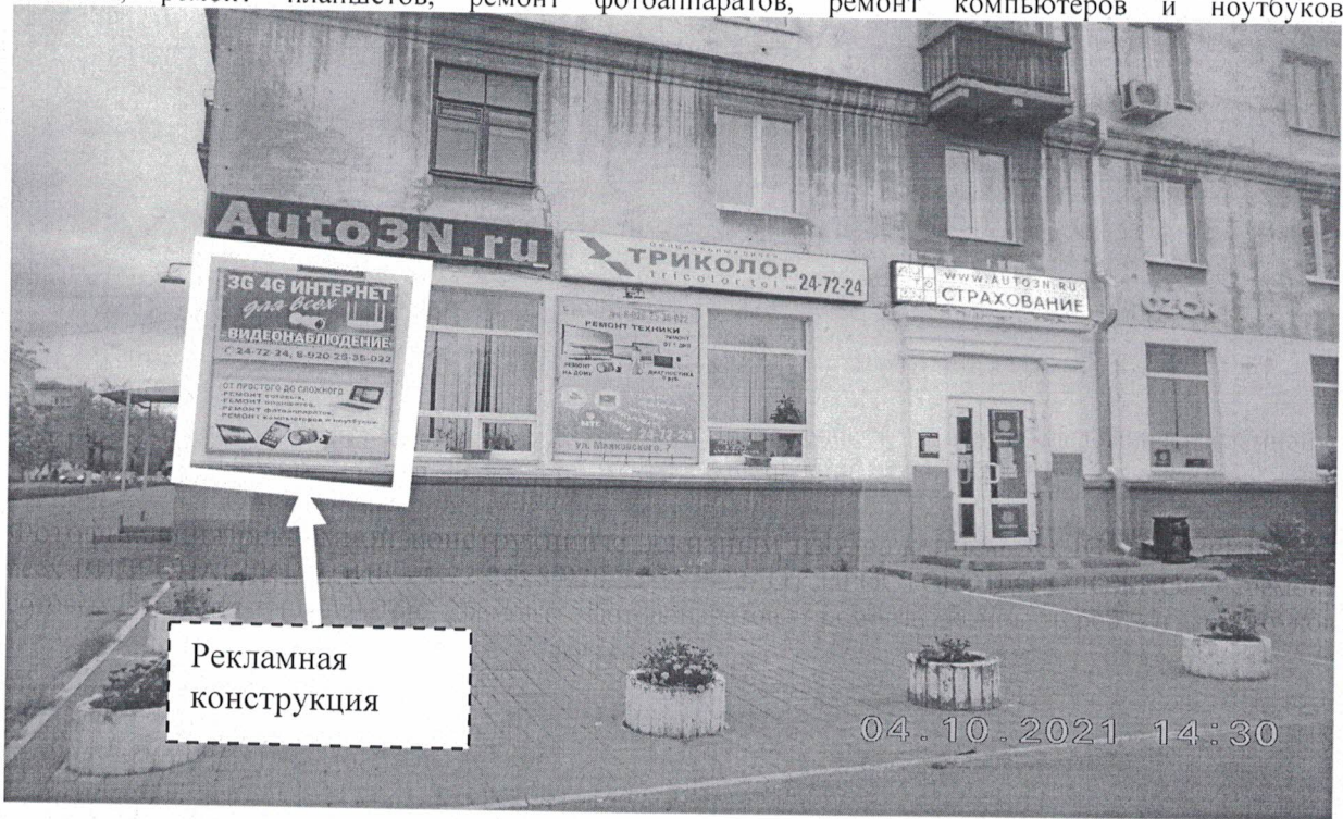
Фото № 1: Панорамный вид размещения рекламной конструкции
