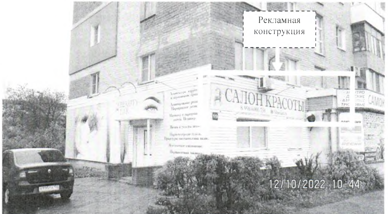
Фото № 1: Панорамный вид размещения рекламной конструкции
