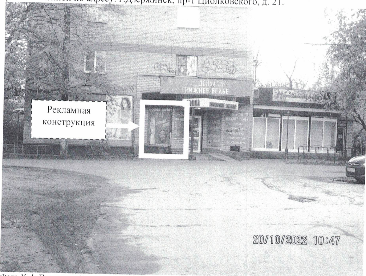
Фото № 1: Панорамный вид размещения рекламной конструкции
