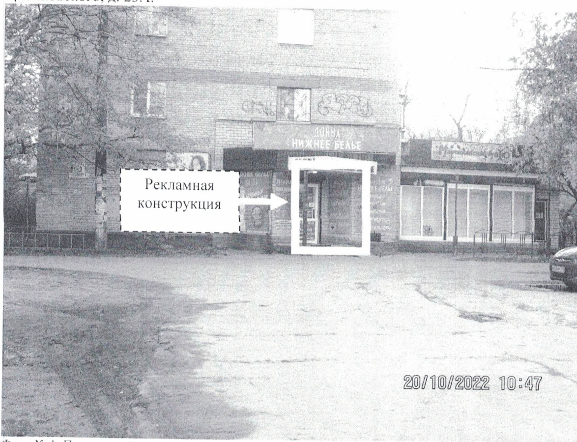
Фото № 1: Панорамный вид размещения рекламной конструкции
