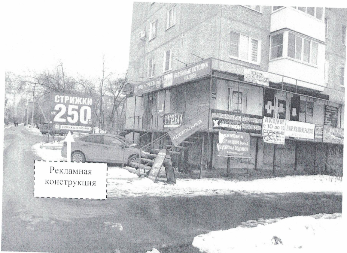
Фото № 1: Панорамный вид размещения рекламной конструкции
